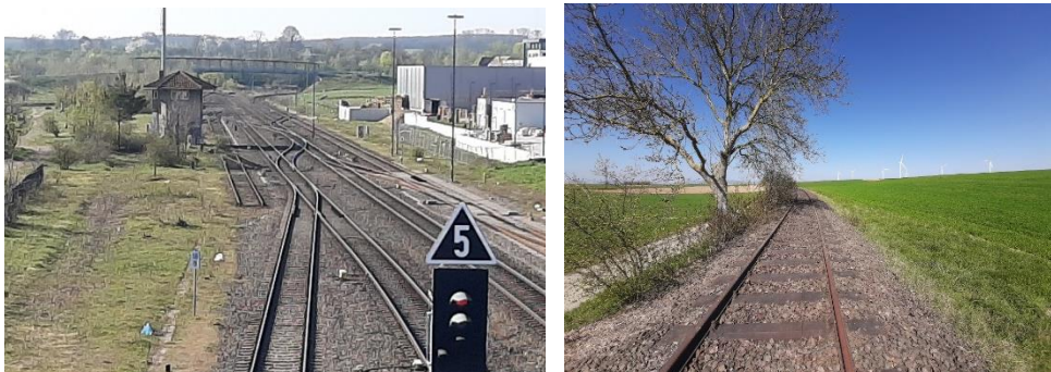
Streckenansfang im Bahnhof Landau und Zustand der Strecke nördlich von Herxheim
