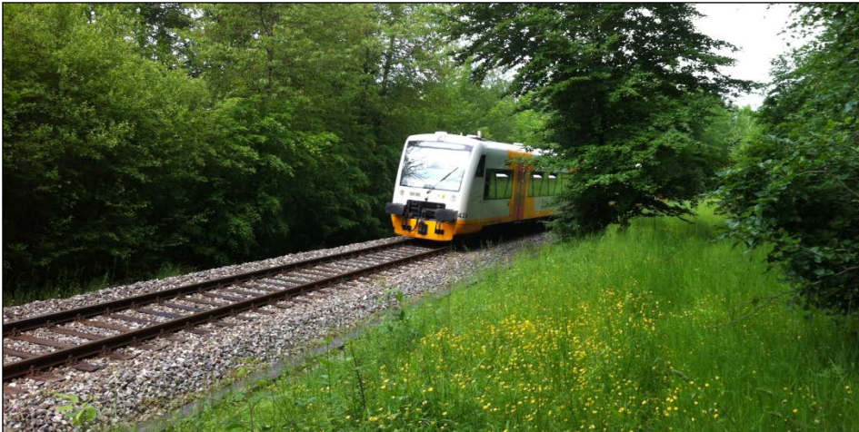
Infrastruktur vor dem zweigleisigen Ausbau
